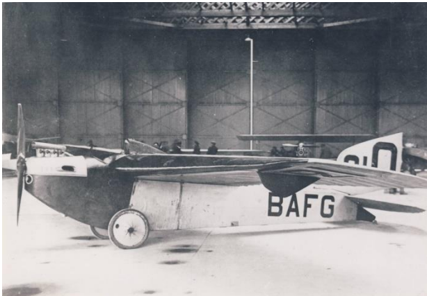
Au hangar à Lympne en septembre 1923, le Castar montre bien son moteur Sergant de même que le réservoir de carburant (tous deux amovibles) servant d'appui-tête pour le pilote. (KLM-MRA)
