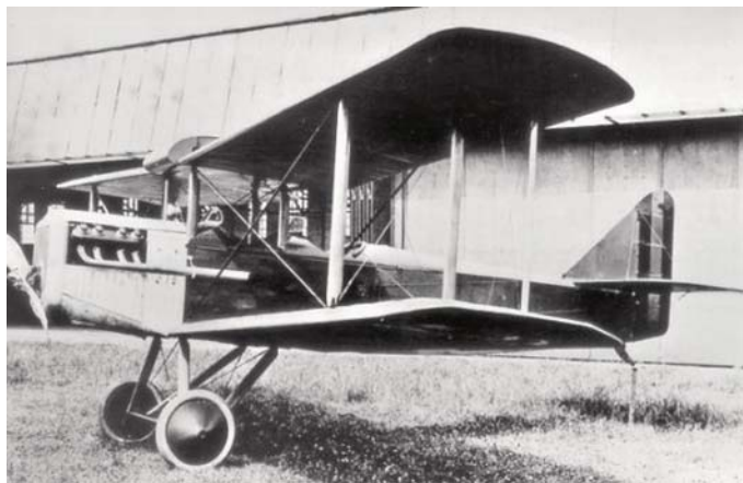
Seul exemplaire du RSV 26-140 gréé du moteur belge Minerva de 140 CV qui fut remotorisé en 1929 avec un moteur en étoile Lynx de 215 CV avant de retrouver son moteur d'origine. (MRA)
