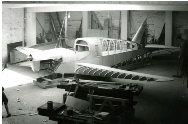
Construction du W 4 vers 1936 dans l'atelier de Schaerbeek.
