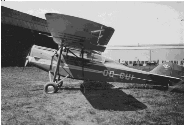
Le Saint-Michel SG.2 du Comte de Looz-Corswarem avec lequel il rallia le Cong. Cet appareil est muni d'un habitacle fermé et d'un moteur De Havilland Gipsy II de 105 HP. (AELR)
